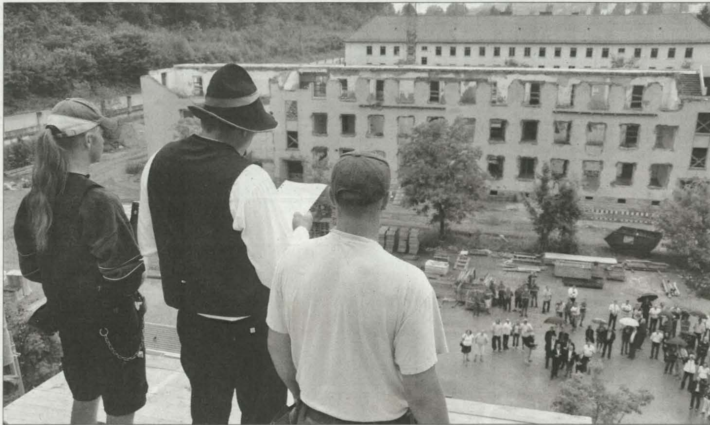
Glückauf: Von hoch droben grüßten die Handwerker beim Richtfest auf dem Kasernenareal die Festgäste.
