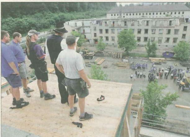
Die ehemaligen Militärgebäude sind noch eine große Baustelle, doch zeigt der gestrige Richtspuch den beachtlichen Fortschritt. FOTO: BREITHAUPT
