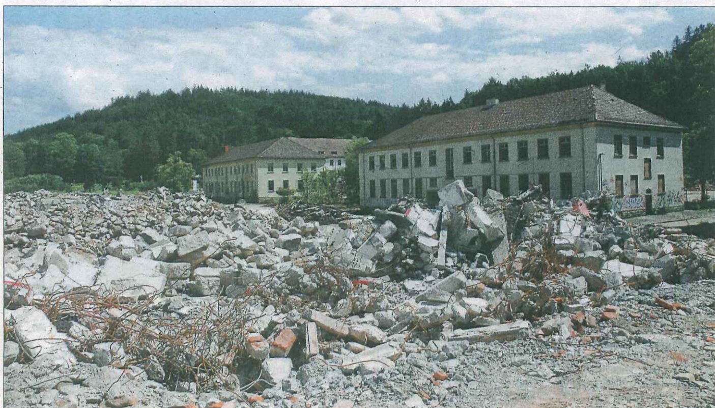
Noch türmt sich der Bauschutt meterhoch auf dem Lahrer Kasernenareal, doch es kommt Bewegung in die Sanierung: Die Arbeiten an den Bestandsgebäuden beginnen im September. Fotos: Stiefenhofer
