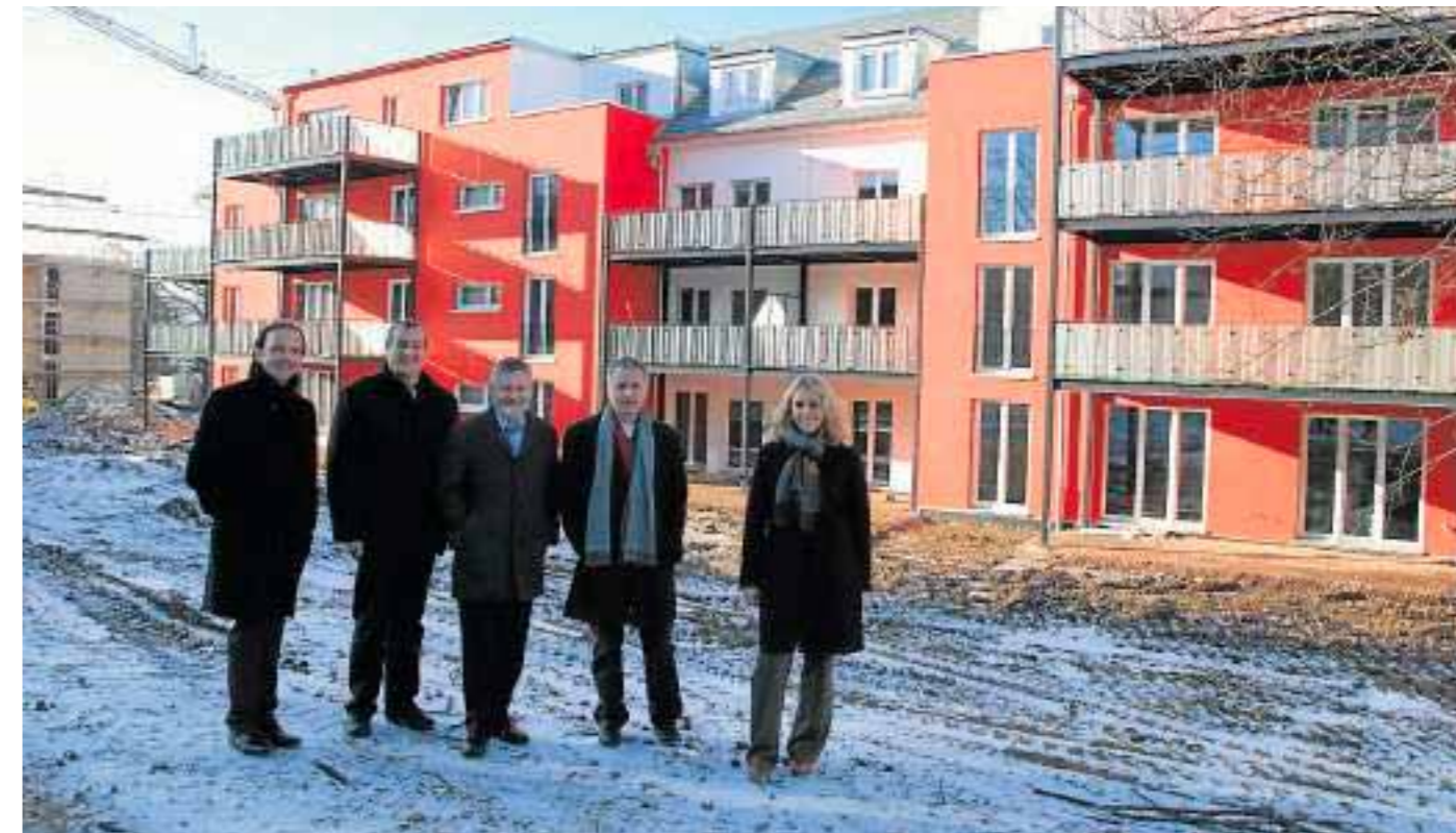
Bauwert-Geschäftsführer Uwe Birk (li.) und Architekt Stefan Emslander (2. v. re.) zeigten OB Dr. Heike Kaster-Meurer, BKEG-Geschäftsführer Dietmar Canis (Mitte) und BKEG-Projektleiter Rolf Riecker auch das Außengelände hinter dem ersten fertig sanierten Haus in der Carl-Schurz-Straße. Foto: Isabel Mittler
