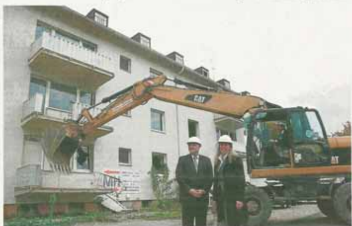
In der Carl-Schurz-Straße erfolgt die weitere Umwandlung von US-Wohnungen in moderne Eigentumswohnungen. Foto: I. Mittler
