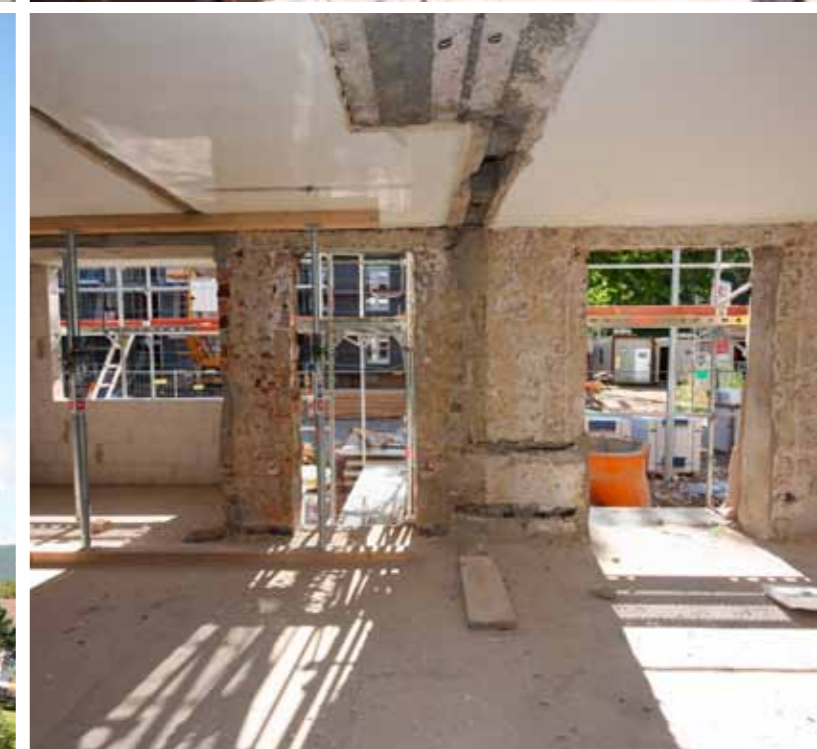
Der Aufzugschacht wird herausgebrochen.
